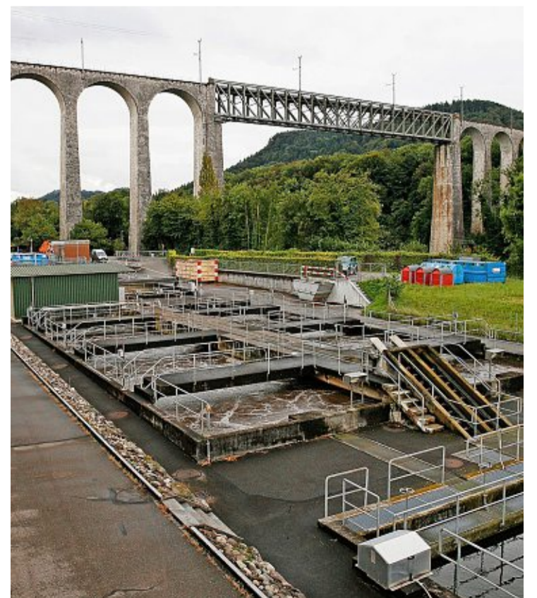
Die Abwärme der Kläranlage in Eglisau heizt rund 220 Haushalte ohne Ausstoss von klimaschädlichen Gasen. Archivfoto: Madeleine Schoder
